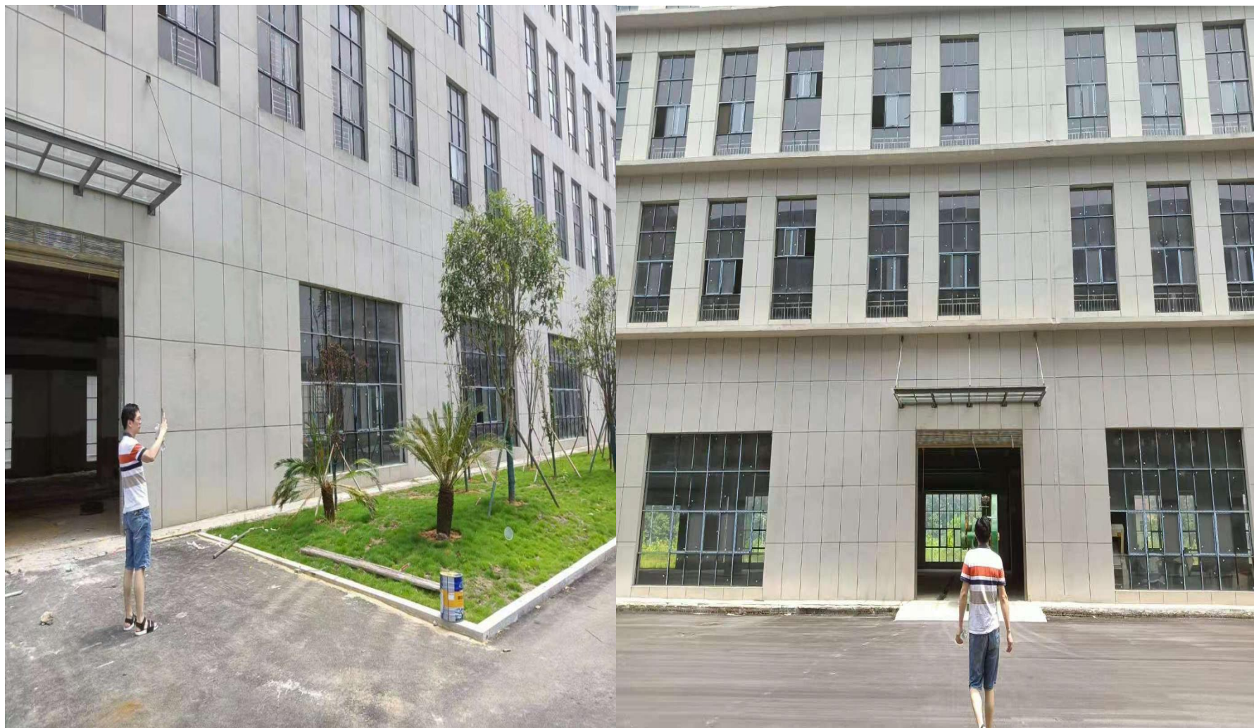
附图 7 工程师勘察现场及项目四周环境现状照片
